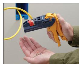
6. Проводники заделаны, торчащие концы обрезаны, монтаж успешно завершен.
