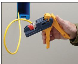
4. Проверить, что розетка плотно вошла в паз гребенкой с контактами в сторону ножей инструмента.
