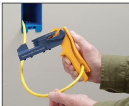
1. Удалить оболочку встроенным или обычным инструментом для зачистки.
